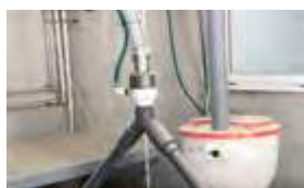
Vanne de distribution avec l'injecteur AWI® (Automatic Water Injection).
