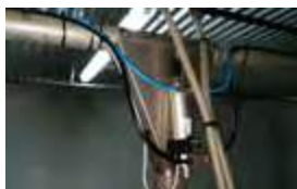
Vanne inox à vérin sur la chaîne d'alimentation.
