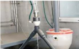
Vanne de distribution avec l'injecteur AWI® (Automatic Water Injection).
